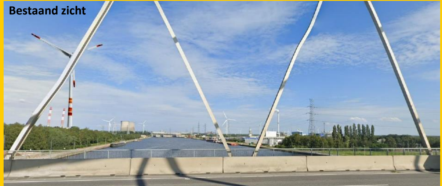
Zicht na realisatie Zuidwind 2.0
